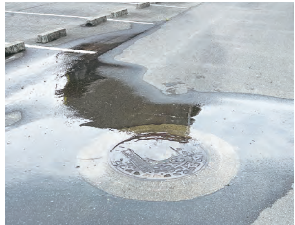
諸の木支線の空気弁からの漏水（刈谷市）
