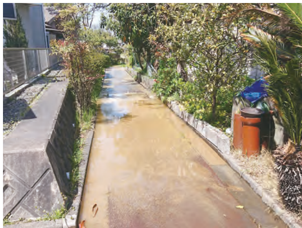
八幡第二支線の漏水による陥没（知多市） 塩化ビニル管 VUφ200mm
