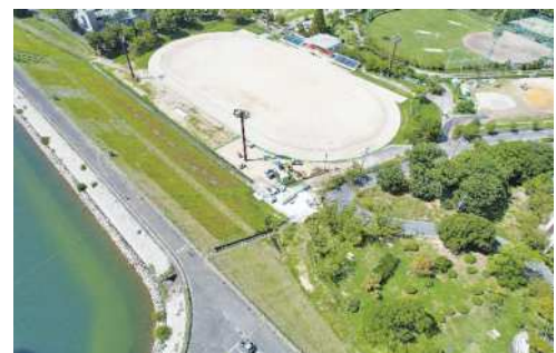
耐震補強を完了し満水になった三好池
