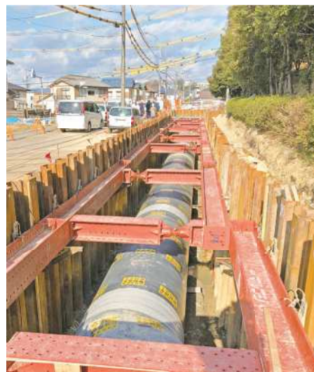
三好支線水路改修工事の様子
